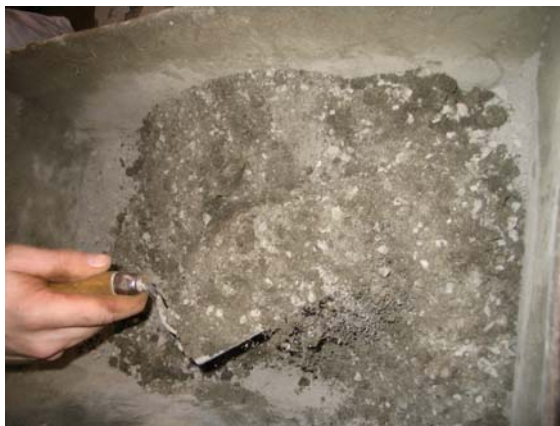
a) Mistura do concreto
