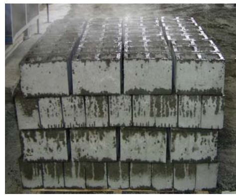
d) Retirada dos blocos da cura
