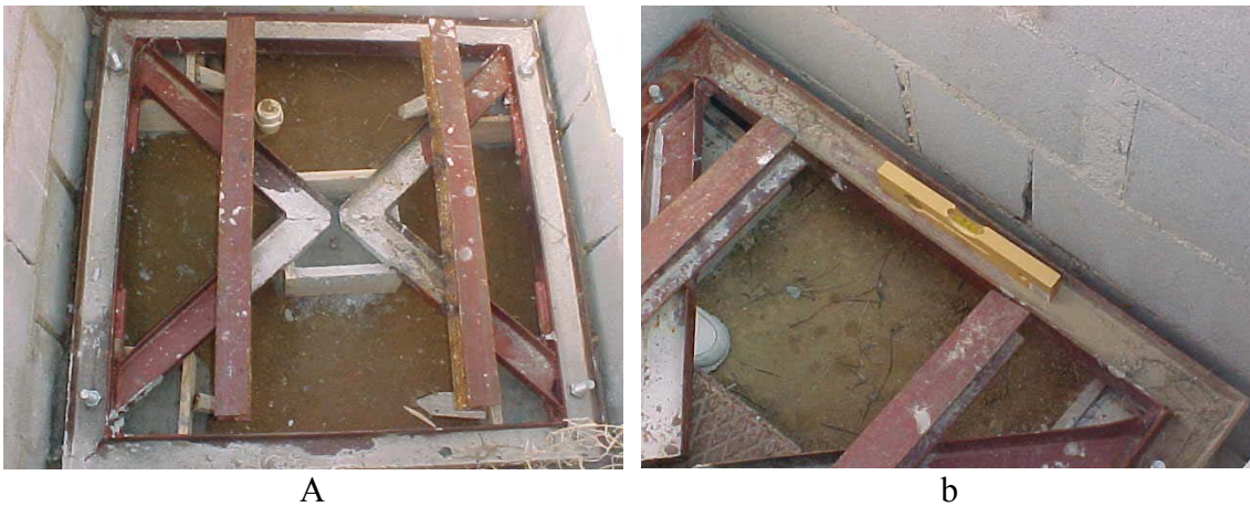
Figura 10 – Estrutura de apoio instalada no fundo do fosso (a), devidamente nivelada (b).
