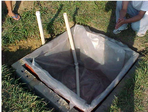
Figura 12 – Vista do revestimento da caixa e montagem dos drenos.
