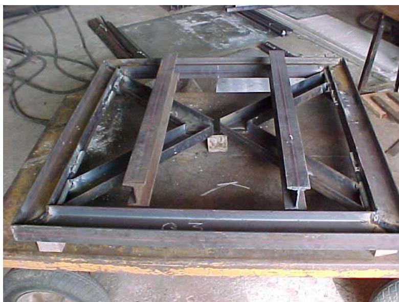
Figura 6 – Vista da montagem do quadro de apoio.
