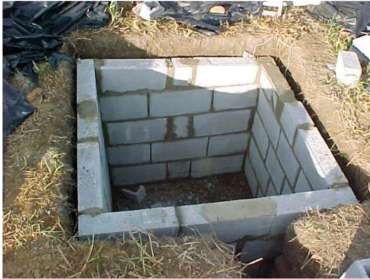
Figura 9 – Caixa de blocos de concreto para receber o lisímetro.
