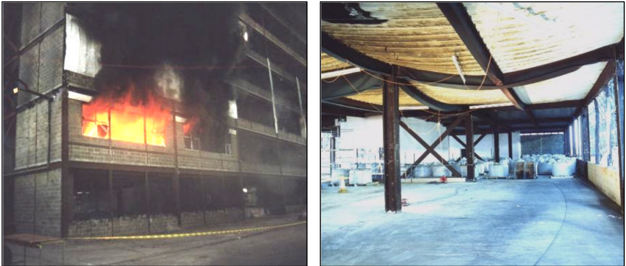
Figura 2.3 - Aspecto do prédio experimental ensaiado em Cardington: (a) vista externa durante o incêndio; (b) vista interna após a extinção das chamas
