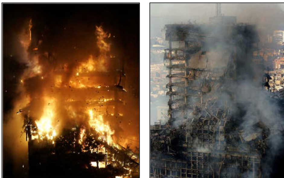
Figura 2.1 - Incêndio na torre Windsor: (a) vista externa durante o incêndio; (b) vista externa após a extinção das chamas
