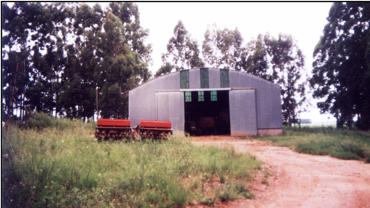
Figura 7: Infra-estrutura e máquinas modernas no assentamento Ramada – Júlio de Castilhos/RS.
