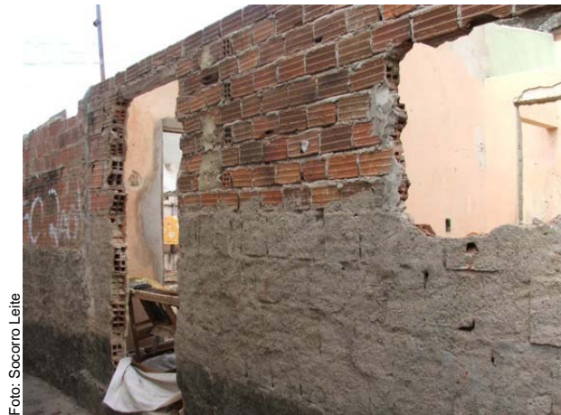
Figura 10 - Imóvel pronto para ser demolido
