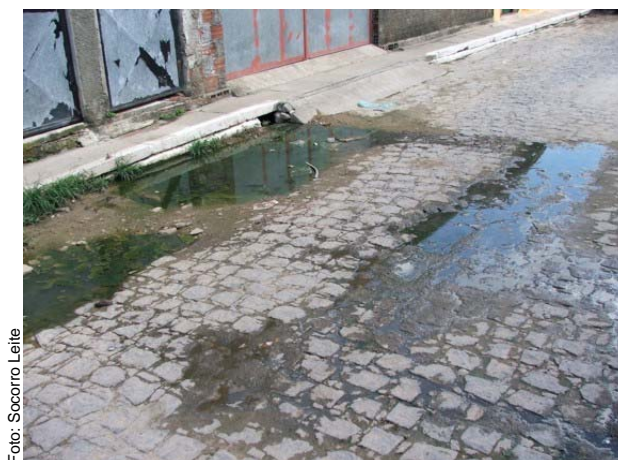
Figura 21 - Esgoto correndo a céu aberto em Asa Branca
