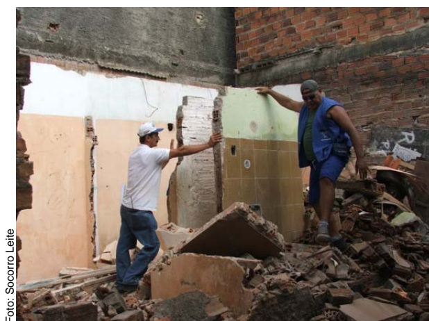
Figura 16 - Demolição de uma das casas indenizadas
