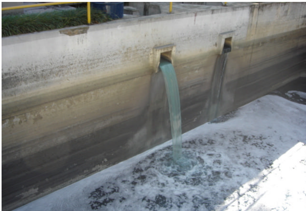
IMAGEM 02: Tanque de Equalização da Indústria Têxtil Jaraguá S.A
