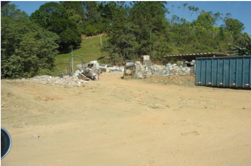
IMAGEM 04: Depósito de Lixo a céu aberto
