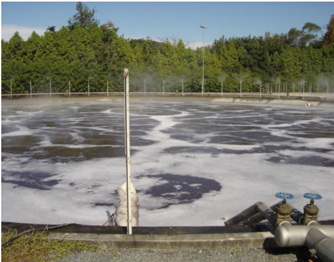
IMAGEM 01: Tanque de equalização da Indústria Têxtil Blumenau S.A
