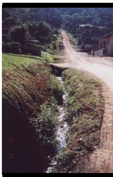
D.B. (jul./2005) FOTO 11 – curso d'água perene de pouca vazão que foi canalizado para ceder espaço às edificações e que escoo ao longo de uma via.
