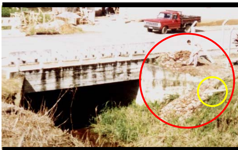
FOTO 13 - Circulado em vermelho despejo de detritos de construção no ribeirão Chico de Paulo. Com destaque amarelo, ligação clandestina de esgoto.
