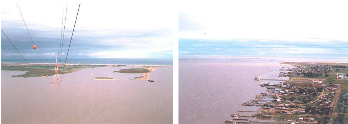
FIGURA 8.16: Vista do topo da torre de concreto das áreas do entorno
