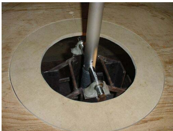
FIGURA 4.8 – Eixo do stick em relação ao chão do túnel
