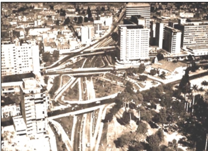
Figura 4.7 – Viadutos produtos do Plano Piloto (pontes sobre a Avenida El dorado) Fonte: WIKIPEDIA, 2006.
