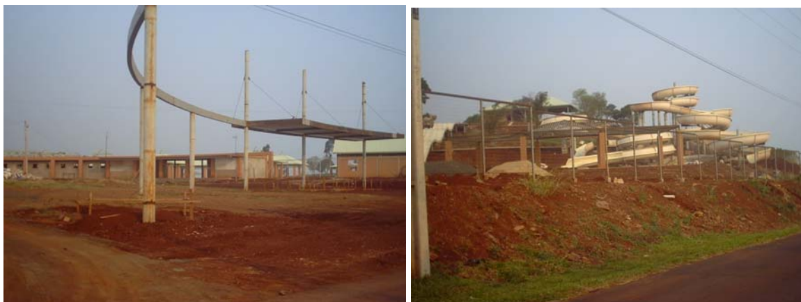
CONSTRUÇÃO DO PARQUE AQUÁTICO TERMAL
