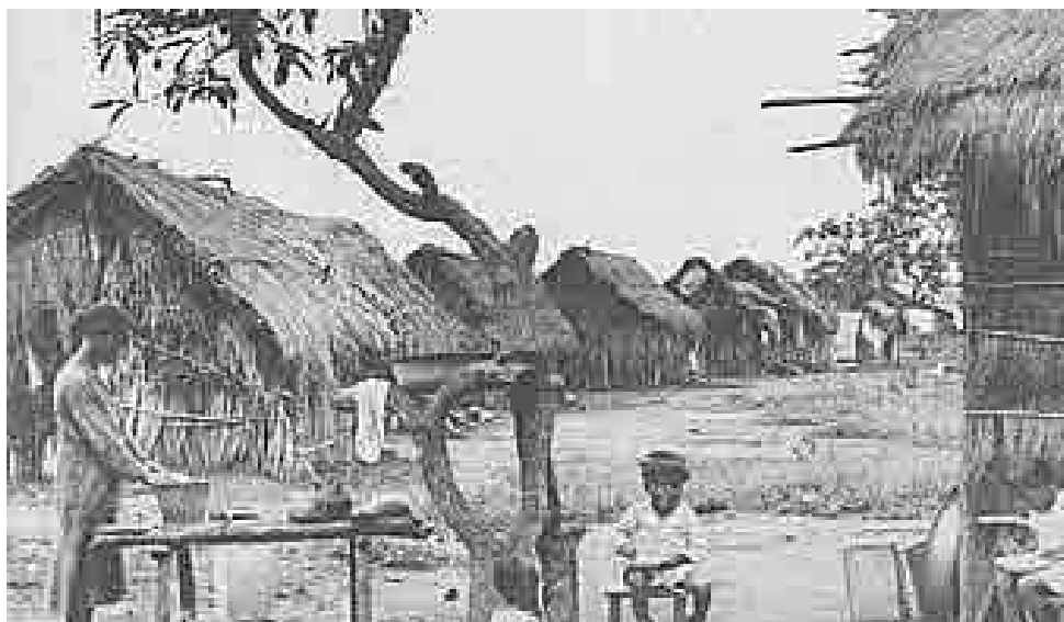
Figura 1.2 Casas de funcionários na Rua 20 próximo ao córrego botafogo.
