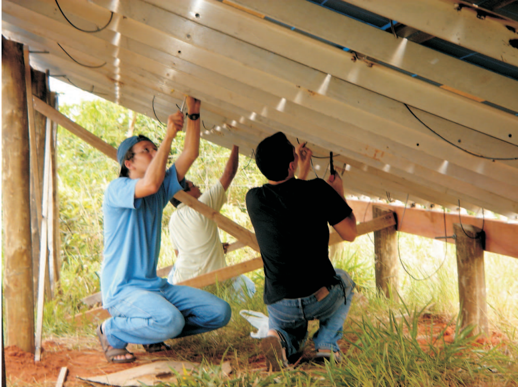
Figura 3.16: Montagem do gerador fotovoltaico.
