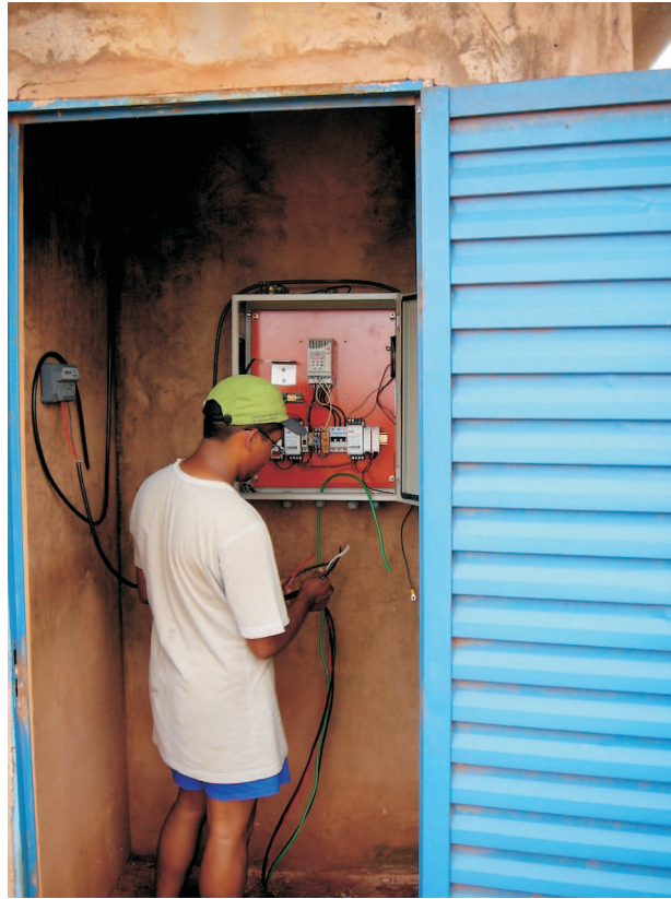
Figura 3.18: Instalação dos equipamentos de condicionamento de potência.
