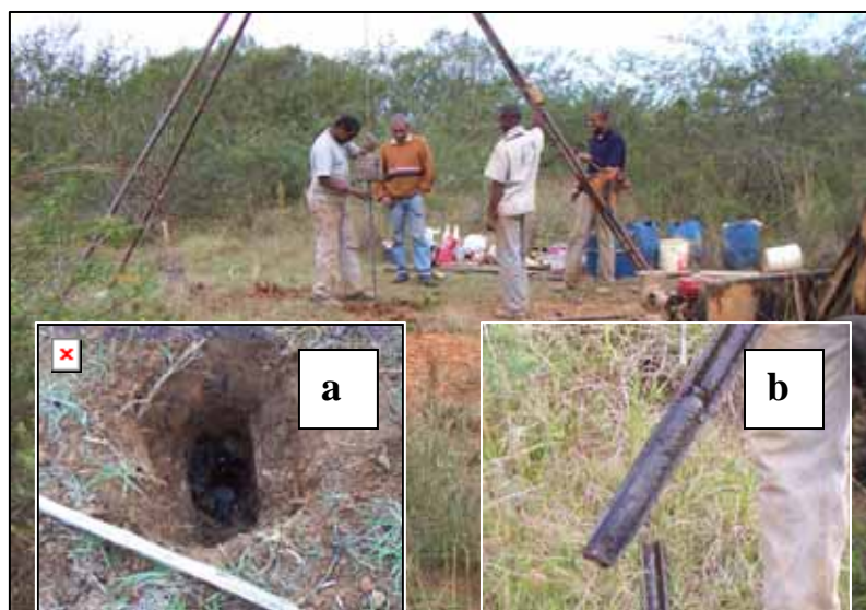
Figura 4.3: execução do ensaio SPT-B; (a) furo de sondagem preenchido com solução ácida; (b) amostra de solo contaminada
