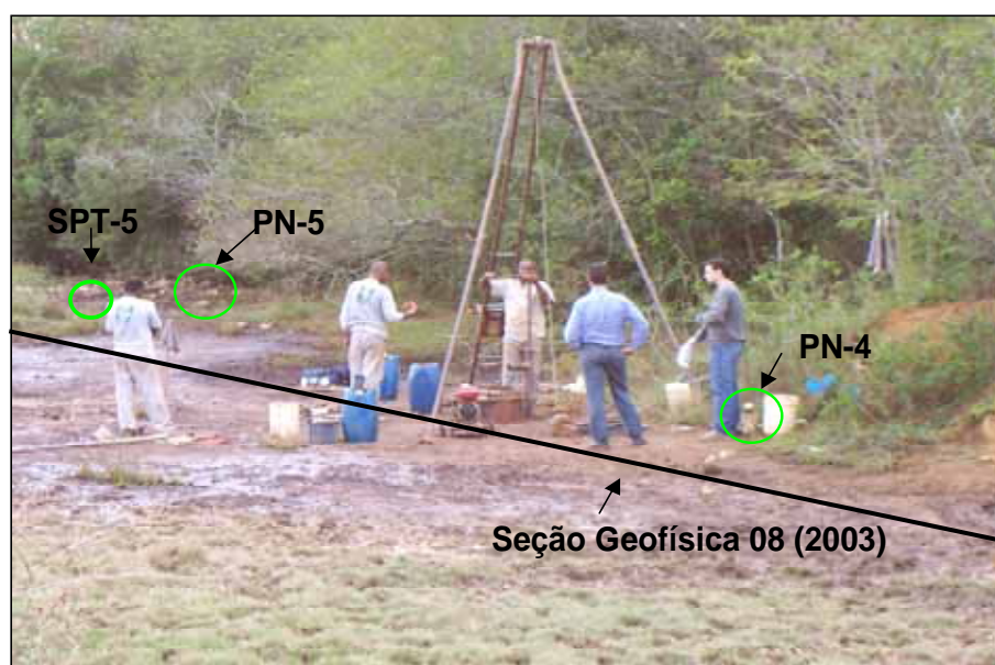
Figura 4.2: execução do furo de sondagem SPT-4
