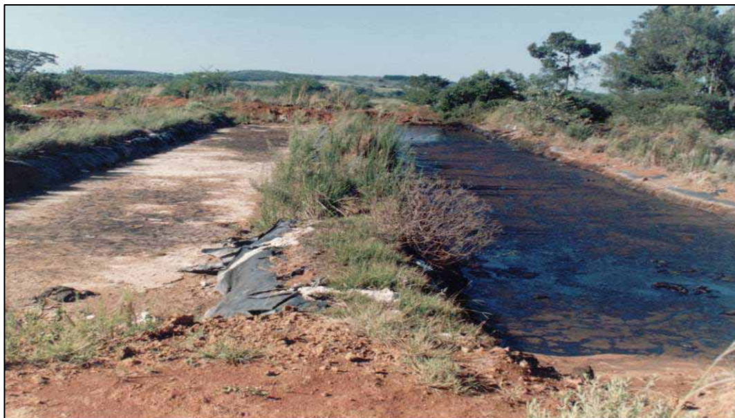
Figura 3.4: valas preenchidas com borra ácida (antes da aplicação da cobertura de aterro)
