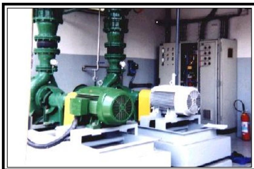
**Figura 5.1. Motores Alto Rendimento (esquerda) e Padrão**
