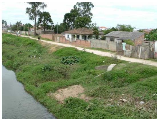
FIGURA 18 – MARGEM DO RIO ATUBA NA COMUNIDADE DO JARDIM ACRÓPOLE ANTES DA RELOCAÇÃO
