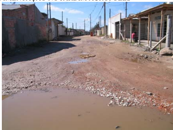
FIGURA 31 – RUA SEM PAVIMENTAÇÃO NO JARDIM ACRÓPOLES
