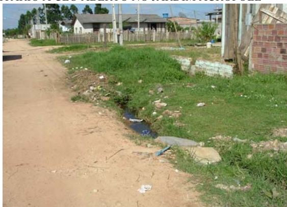
FIGURA 23 – ESGOTO SANITÁRIO À CÉU ABERTO NO JARDIM ACRÓPOLE
