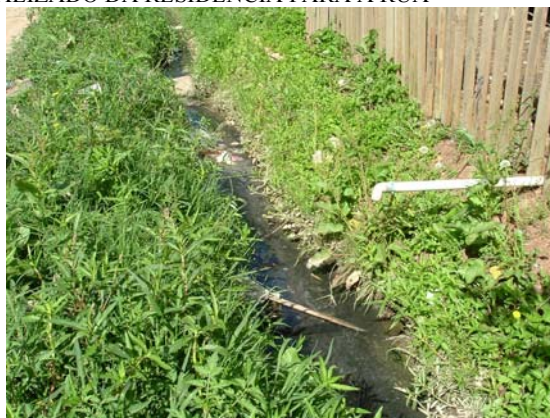
FIGURA 24 – ESGOTO CANALIZADO DA RESIDÊNCIA PARA A RUA
