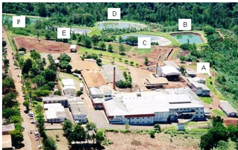
Figura 4 - Vista aérea do sistema de tratamento de efluentes da unidade frigorífica.
