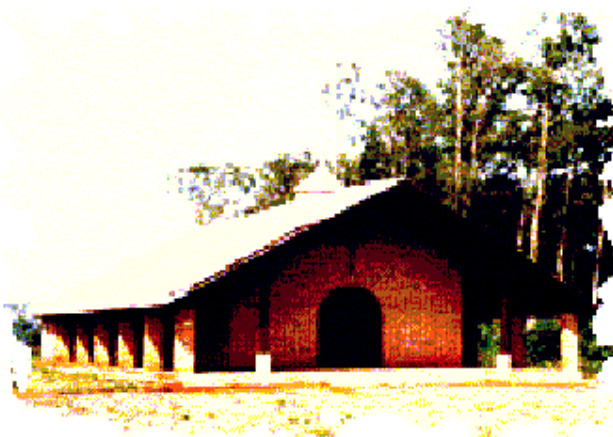
Figura 14: Vista da Capela da Fazenda Ubatuba Fonte: Rita Ribeiro, 2004.
