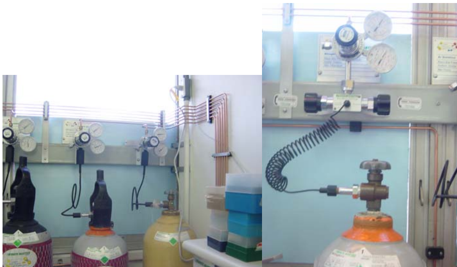
Figuras 4 e 5 – Detalhe da ligação dos cilindros
