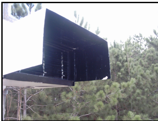
Figura 4.11 – Instalação Prática do Painel Sensor
