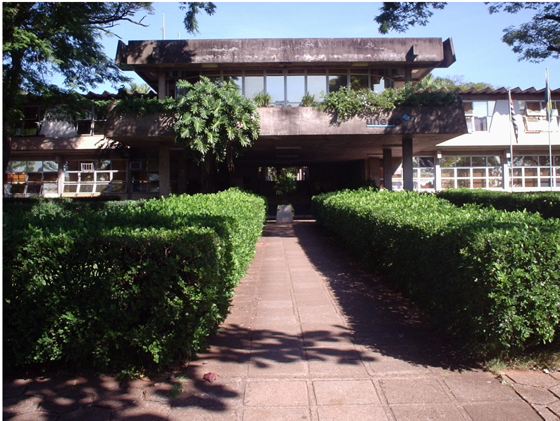
Figura 10: Vista frontal do prédio da FCT Unesp Presidente Prudente (atual)
