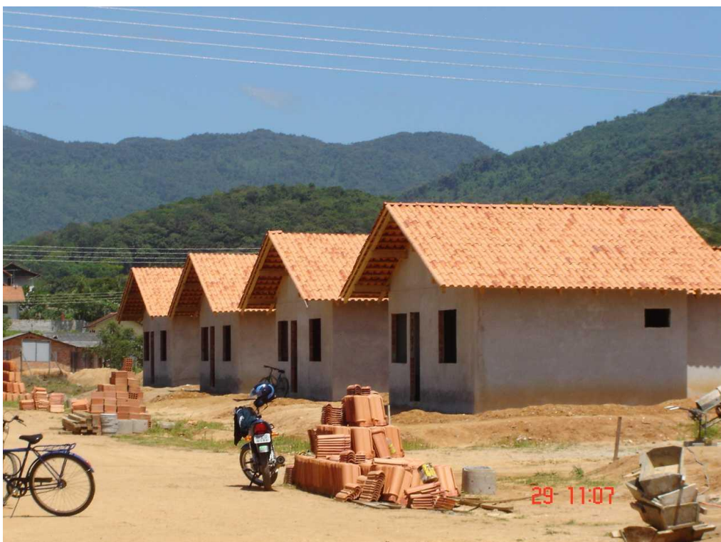
FOTO 2 – Conjunto Habitacional Rio dos Cedros em Execução
