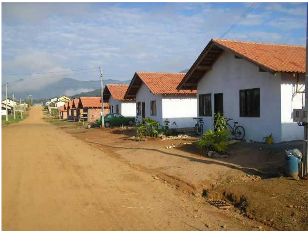
FOTO 3 – Conjunto Habitacional Rio dos Cedros Concluído 1ª etapa
