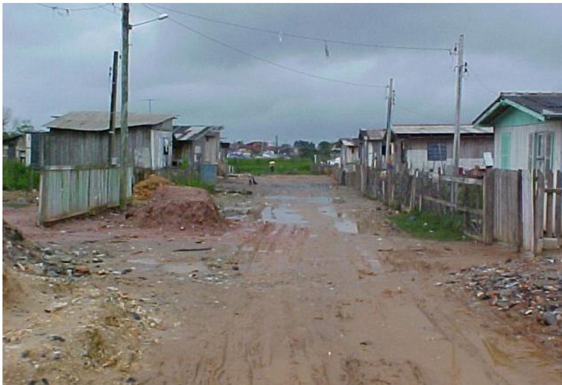
Figura 19 – Ausência de pavimentação e drenagem II Foto: Oswaldo Schuch – outubro/2004
