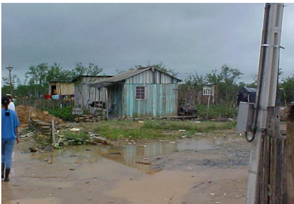
Figura 18 – Ausência de pavimentação e drenagem I Foto: Oswaldo Schuch – outubro/2004
