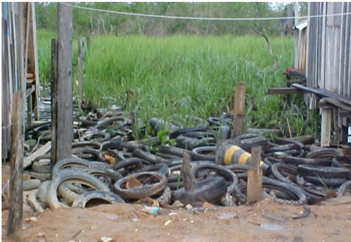
Figura 43 – A utilização de pneus como material de aterro
