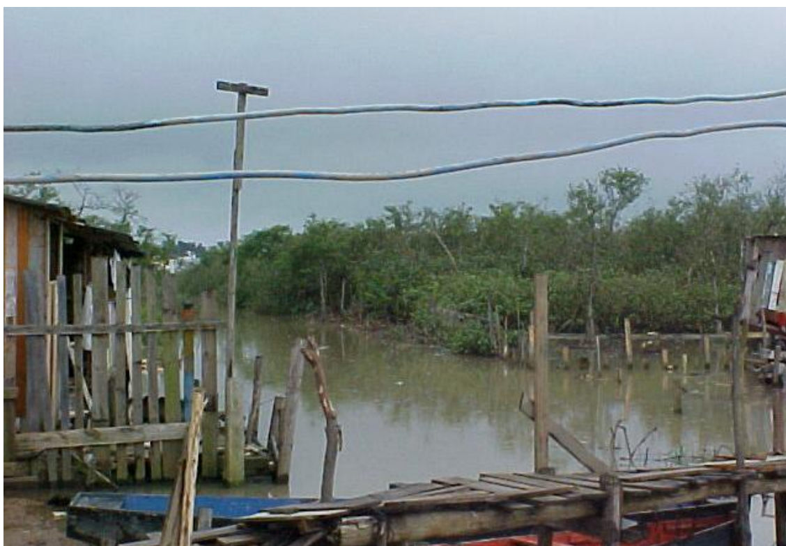
Figura 35 – Fiação elétrica passando no espaço aéreo sem proteção
