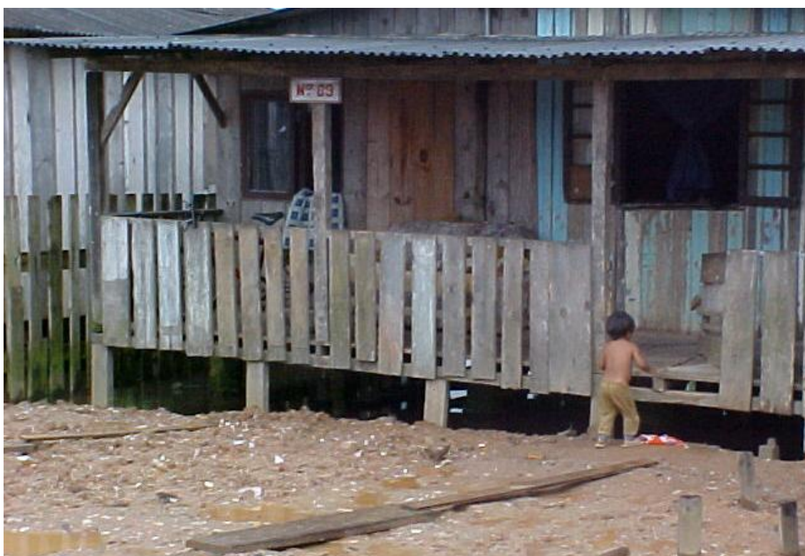
Figura 8 – Aterro e palafita para evitar a submersão pelas águas Foto: Oswaldo Schuch – outubro/2004
