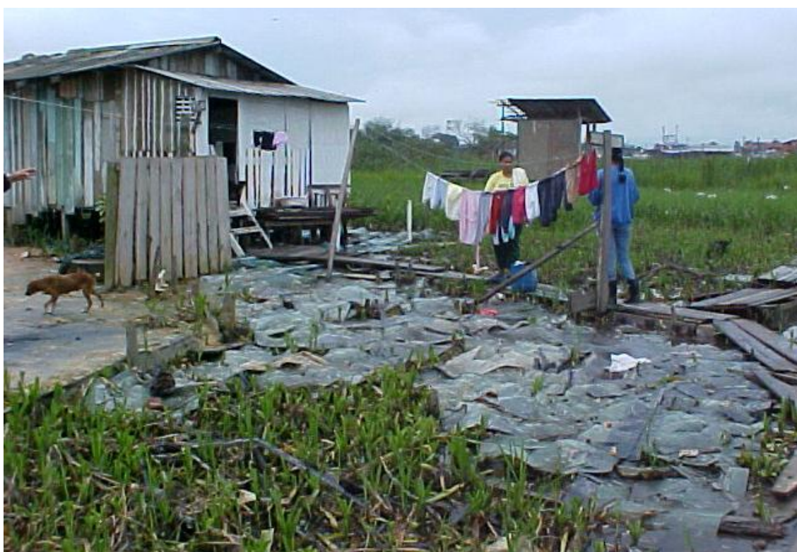
Figura 42 – A utilização de pára-brisas de veículos como material de aterro
