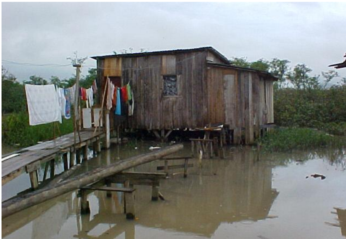
Figura 37 – Tubulação de esgoto apoiada sobre cavaletes.
