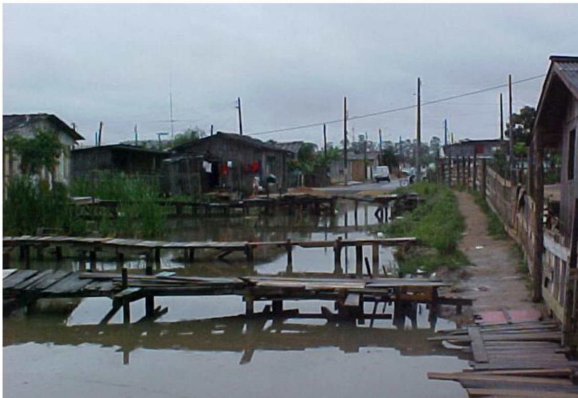
Figura 13 – Vista do conjunto à margem da “vala”
