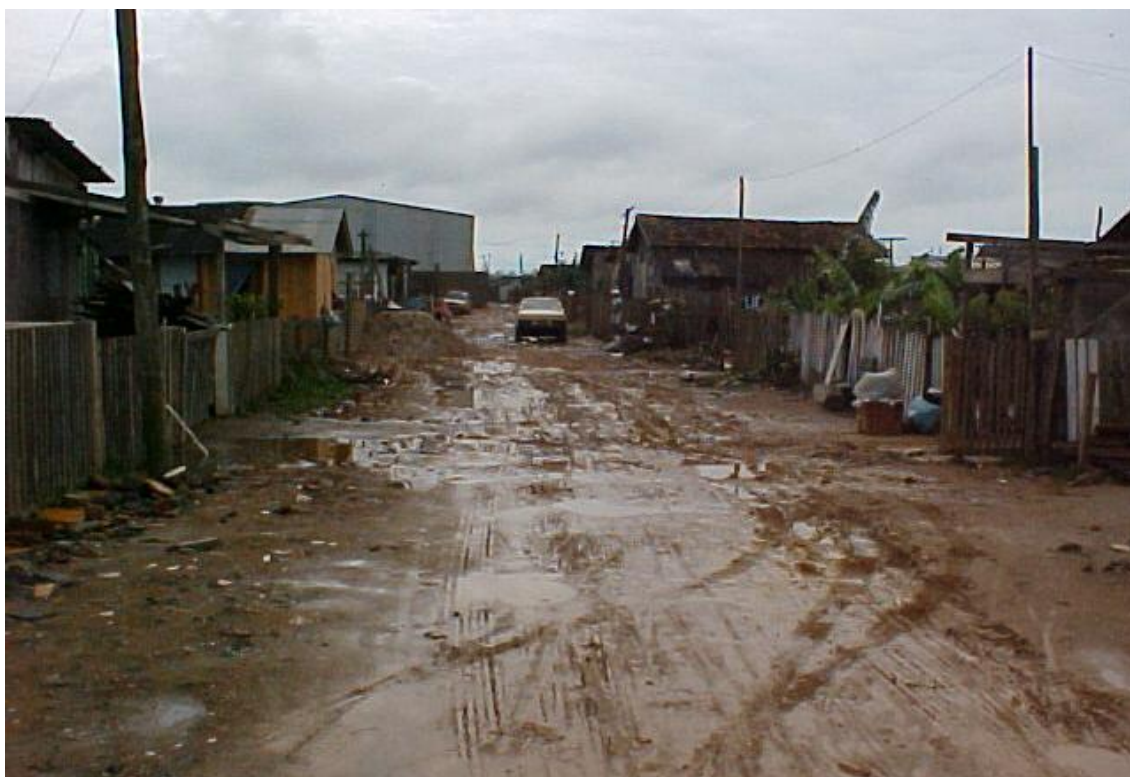
Figura 20 – Ausência de drenagem e pavimentação III Foto: Oswaldo Schuch – outubro/2004
