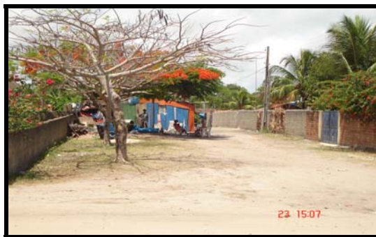
Figura 9.1 – Invasão da rua para construção de moradia de baixa renda em Maracáipe (Jan/06)
