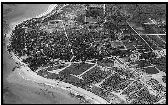
Figura 8.12-Foto Aérea Muro Alto,1969 Fonte: http://www.portodegalinhas.com.br/
