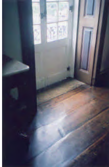
Fig. 99 – CASARÃO DA MADALENA, RECIFE – PE, PORTAS-JANELAS. Portas-janelas de duas folhas envidraçadas, de influência cultural francesa. Notamos soleira em pedra de lioz e assoalho de tábuas largas, generalidade desde os primórdios do Brasil colônia. (Crédito da Ilustração: Foto da Autora, datada de 2002).
