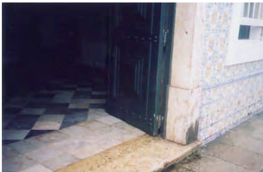
Fig. 97 – CASARÃO DA MADALENA, RECIFE – PE, SOLEIRA.
