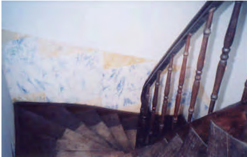
Fig. 106 – CASA 813, RUA OLIVEIRA LIMA, RECIFE – PE, ESCADA.
