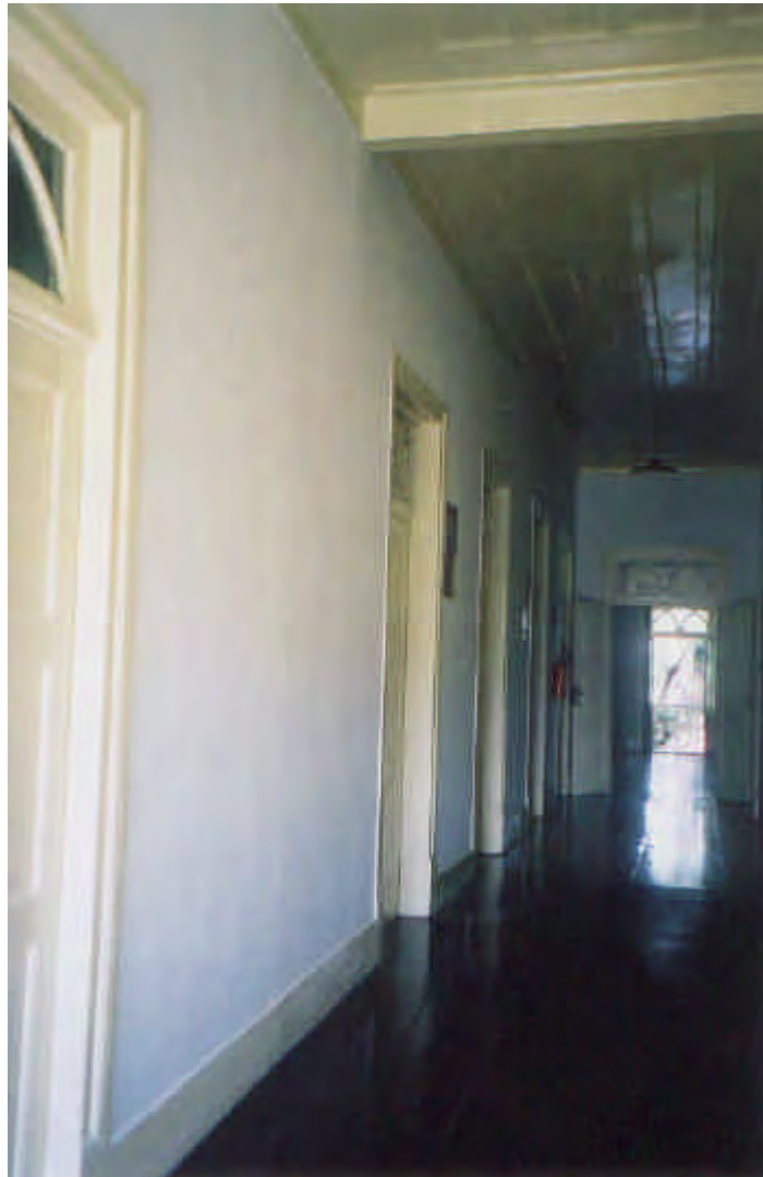
Fig. 117 – CASA 150, RUA BENFICA, RECIFE – PE, CIRCULAÇÃO SUPERIOR. Interior da residência, mostrando o aspecto da circulação superior, onde podemos perceber o assoalho, o forro em madeira que foi conservado e as portas internas em madeira almofadada, com bandeiras retangulares em vidraça. (Crédito da Ilustração: Foto da Autora, datada de 2002).
