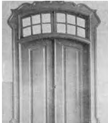
Fig. 11 – PORTA INTERNA DA CASA DO CONDE DOS ARCOS, SALVADOR – BA.
