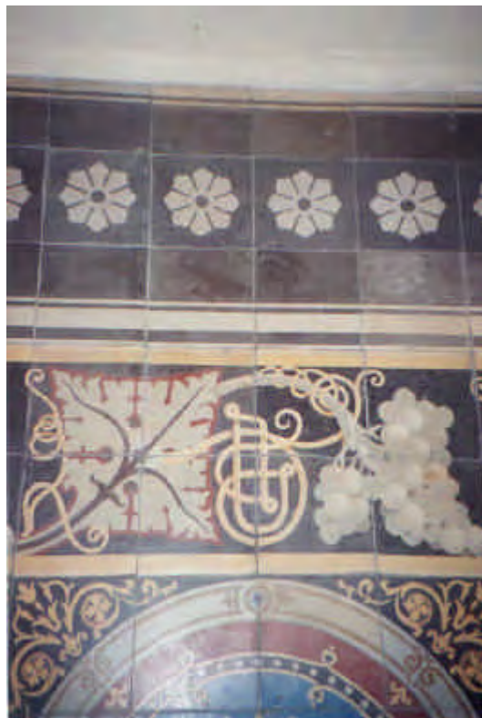
Fig. 124, 125– CASA 1893, AV. 17 DE AGOSTO, RECIFE – PE, PISO DO SAGUÃO PRINCIPAL.
