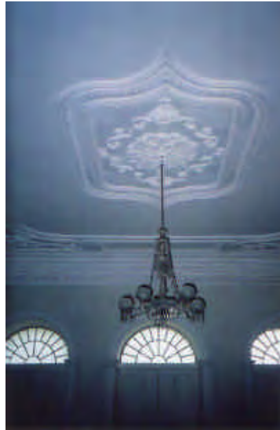
Fig. 86 – SOLAR RODRIGUES MENDES, RECIFE – PE, FORRO EM ESTUQUE .
