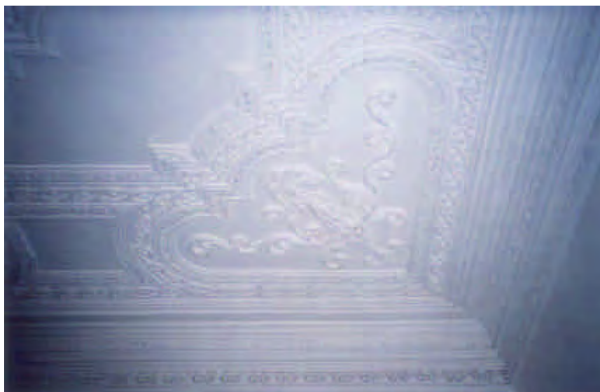
Fig. 84 – SOLAR RODRIGUES MENDES, RECIFE – PE, FORRO EM ESTUQUE. Aspecto do estuque da sala de visitas do andar superior, onde percebemos inspiração no Rococó francês. Anteriormente, quando dos anos de glória do casarão, este estuque era colorido, predominando o amarelo e azul, com grinalda, vultos e florões. (Crédito da Ilustração: Foto da Autora, datada de 2002).
