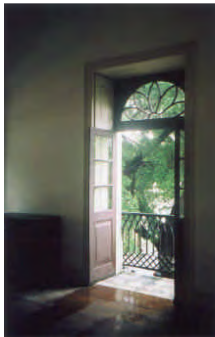
Fig. 107 – Casa 813, RUA OLIVEIRA LIMA, RECIFE – PE, ESQUADRIAS EXTENAS.
