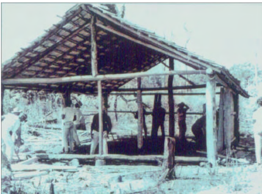
Foto 04: Trabalho em mutirão de construção de barraco de madeira coberta de taubinhas – Fonte FASE-MT – 1988
