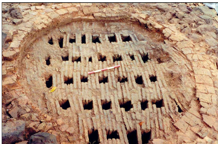
Figura 50. Detalhe do forno do Engenho Uriboca, construído em alvenaria mista (pedra e tijolo maciço), em forma quadrangular, com dimensões de aproximadamente 5m x 5m, e 2,5m de diâmetro na área circular central.
