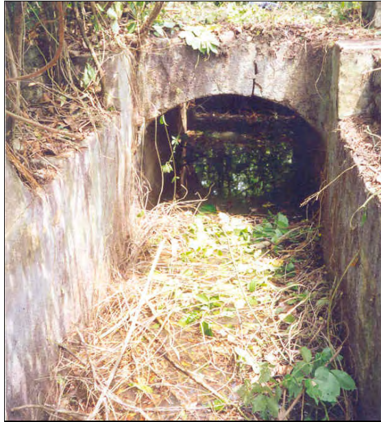
Figura 40. Detalhe do Interior de uma calha situada nas imediações do Engenho Jaguarari, que segundo informação oral local, foi construída no início do século XX, para movimentar uma serraria e gerar eletricidade para uma comunidade que lá existia.
