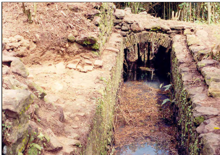
Figura 49. Panorama do interior da calha do Engenho Uriboca, notando-se ao fundo o 1.º trecho da galeria em abóbada de tijoleira, e na lateral à esquerda, a reentrância semicircular, semelhante à calha do Murutucu.
