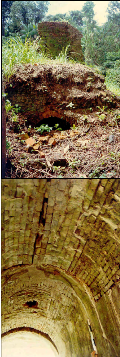
Figura 59. Vestígios de estruturas na área da fábrica do Engenho Murutucu: Detalhe da base da chaminé, em forma octogonal, cuja altura chegava quase a 10m, e que se arruinou na década de 1980 (em cima); e interior do 1.º trecho da galeria da calha, onde percebe-se indícios da reforma de ampliação da abóbada, em técnica construtiva diferente, para suportar a chaminé, o que inviabilizou o uso da roda d'água. (em baixo)
