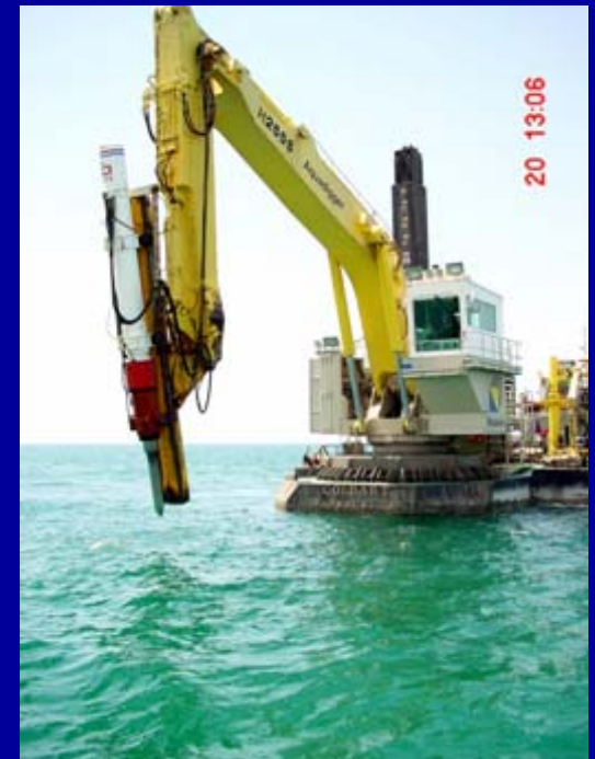
derrocamento com martetele hidráulico
