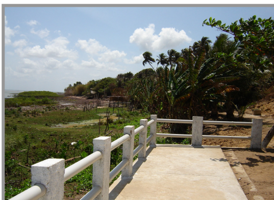
Figura 38 – Aplainamento da falésia para a construção de uma praça.
